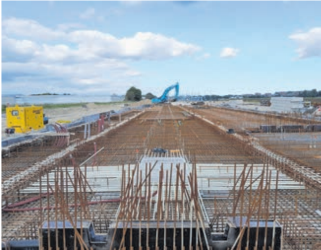
Een deel van de wapening voor de hal is al gereed.
