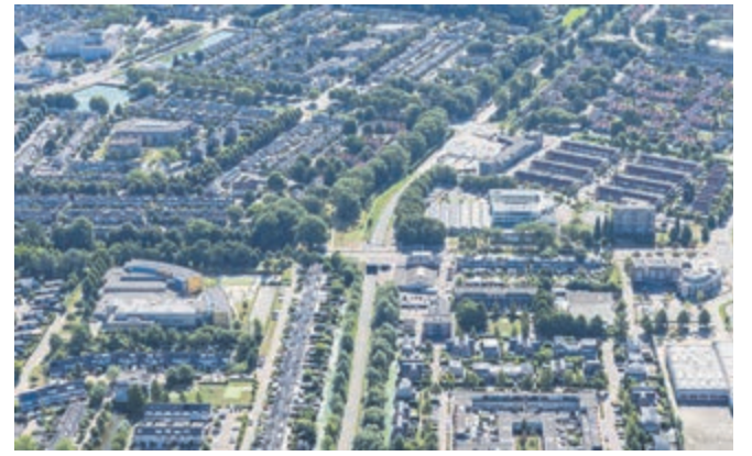
Het viaduct Zijdeweg over de bestaande busbaan, met op de achtergrond het busstation.
