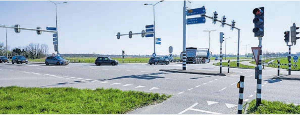
Werkzaamheden op de kruising N201/Hoofdweg tussen Mijdrecht en Vinkeveen. Foto: Provincie Utrecht.
