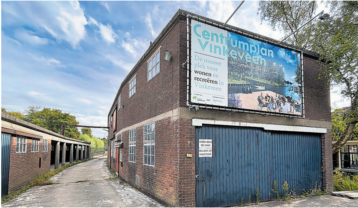
Voormalige betonfabriek De Adelaar met het doek van het project Centrumplan Vinkeveen. Foto: aangeleverd.
