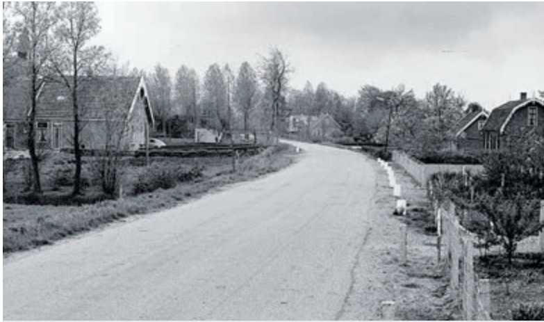
De Cliffordweg in 1962 ter hoogte van Plooy, direct nadat de oude dijk was afgegraven en de verlaagde weg voor het eerst in de geschiedenis van een asfaltlaag was voorzien. (Foto Provinciale Waterstaat Utrecht 1962)
