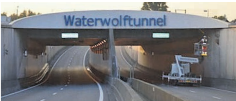
Waterwolftunnel N201. Foto: Provincie Noord-Holland.
