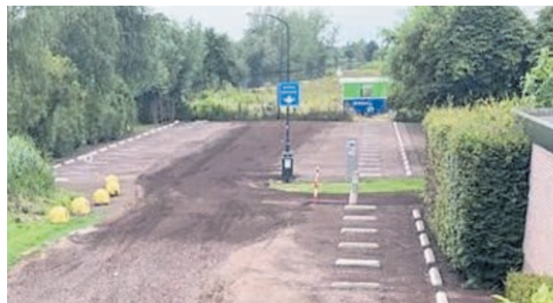
Het opgeknapte parkeerterrein aan Achterbos is van parkeervakken voorzien.
