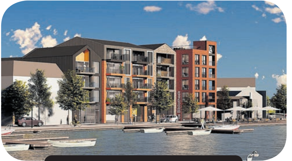
De bouw van Wooncomplex De Rede moet volgend jaar van start gaan
