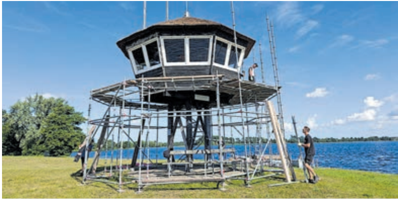
De karakteristieke starttoren op het Starteiland (Eiland 8) op de Vinkeveense Plassen wordt gerenoveerd. Foto: Piet van Dijk.
