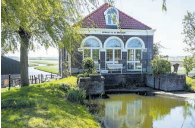
Gemaal bij Bilderdam
