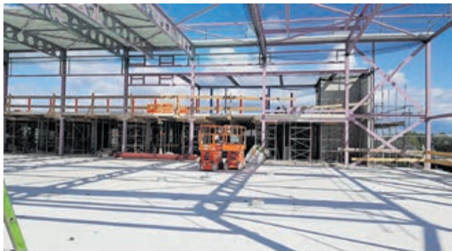
Aanleg dak van het Sporthuis
