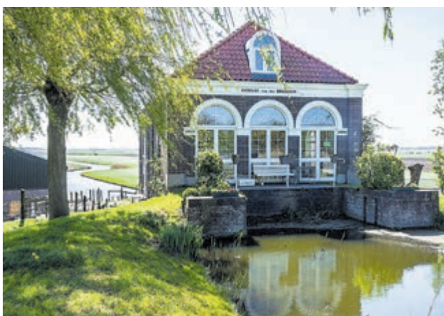
Gemaal bij Bilderdam
