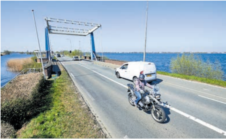
Er wordt 22 mei uitgelegd hoe de provincie de nieuwe brug wil realiseren en wat de gevolgen zijn voor de omgeving tijdens de werkzaamheden. Foto: Provincie Utrecht/Geert van Tol.
