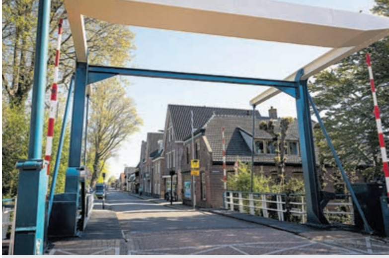
Werkzaamheden aan de Irenebrug in Mijdrecht zijn afgerond. Foto: aangeleverd.
