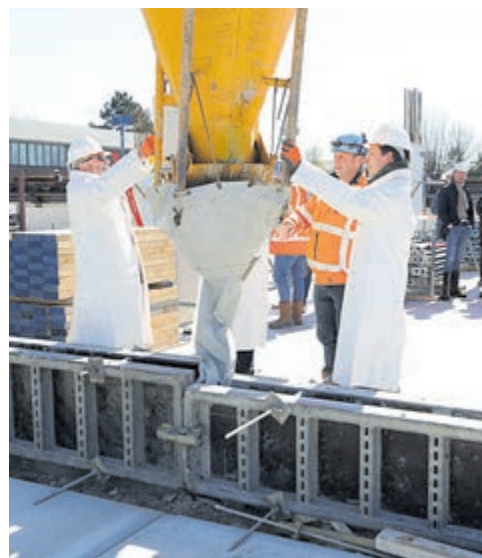
Wethouders Ferry Hoekstra en Jan Hazen verrichten symbolische handeling op de bouwplaats (storten van beton).
