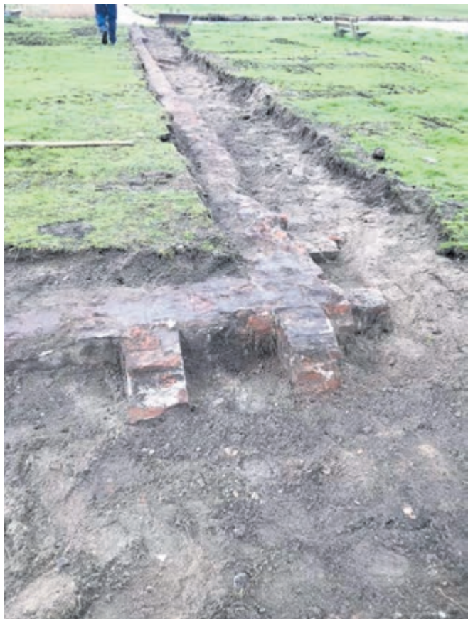
Een toegang tot de kelder werd gevonden
