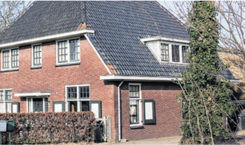
De boerderij aan de Rijksstraatweg 85 wordt verbouwd tot drie woningen en twee appartementen.
