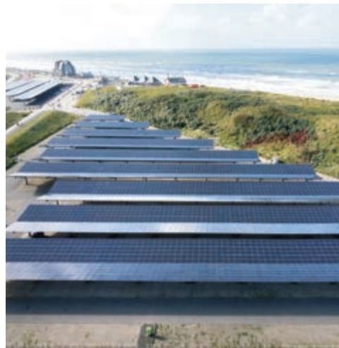
Een voorbeeld van zonnepanelen als overkapping van een parkeerterrein aan zee. Foto: Provincie Noord-Holland
