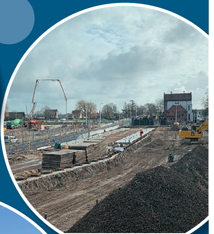
Start aanleg Uithoornlijn
