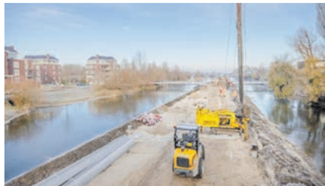
Op de spoordijk wordt komende maanden de trambaan aangelegd
