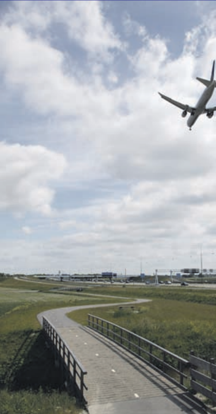
De fiets- en voetgangersbrug ligt aan de linkerkant van de foto lager dan aan de rechterkant. Foto: mw. Madeleine Maat
