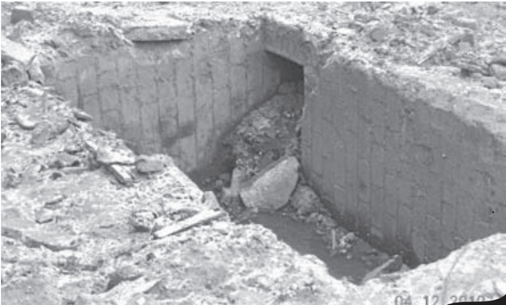
Dit is de gevonden inpandige waterkelder
