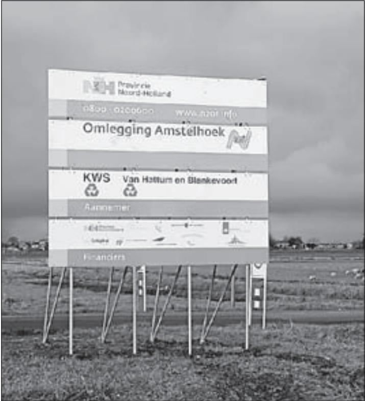
Op de plaats van dit bord aan de N201 richting Uithoorn nabij de Tienboerenweg, komt het nieuwe kruispunt. Er achter in het land wordt komend voorjaar de bouwweg aangelegd
