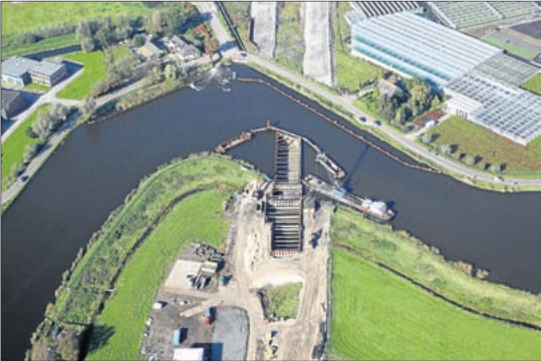
Ontgraving van het eerste deel van het aquaduct aan de Rondeveense kant. Boven aan de foto de overkant van de Amstel met de Hollandse Dijk en het afvoeren van water door het gemaal. Ook is het vervolg van het tunneltracé zichtbaar.
