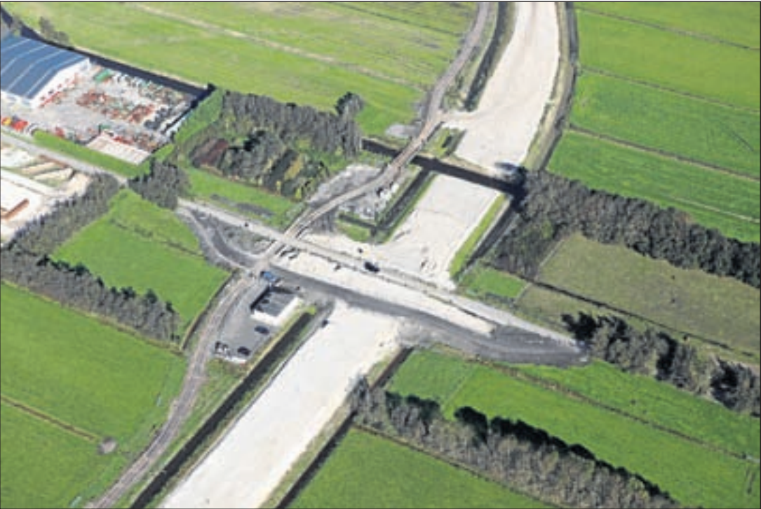
Werkzaamheden aan de N201 ter hoogte van de kruising met de Van Geijnweg. Links in de hoek van de foto het tractorenbedrijf van Roeleveld & Bos. Naast het tracé van de N201 de (tijdelijke) bouwweg wat later een landbouwweg wordt. Naar de bovenkant van de foto toe is richting aquaduct.
