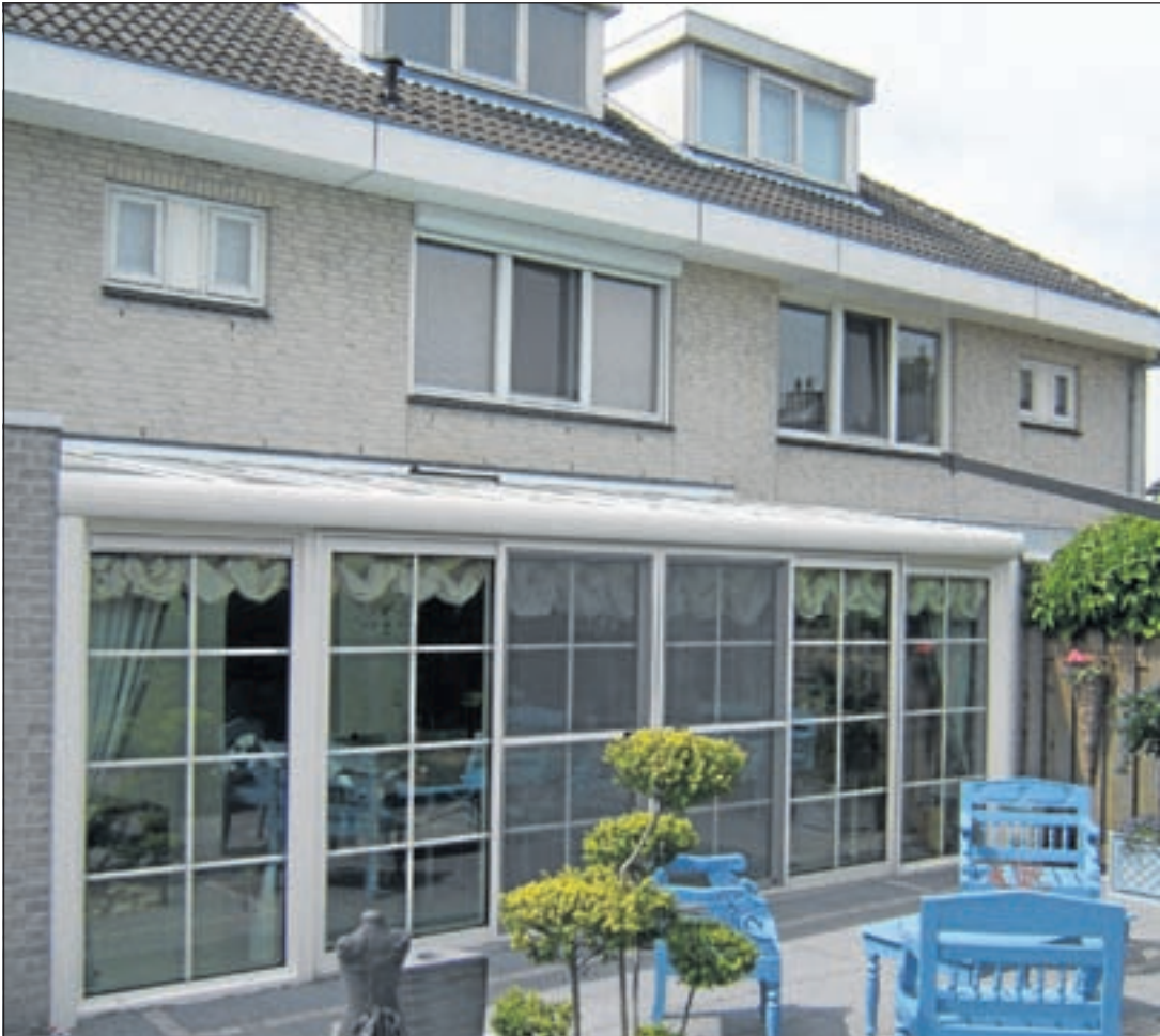
Kozijnen voorzien van geïntegreerde rolluiken op 1e & 2e etage
