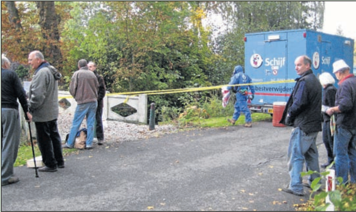
12: Vrij snel volgde het opruimen van de vrijgekomen asbest door een gespecialiseerd bedrijf.
