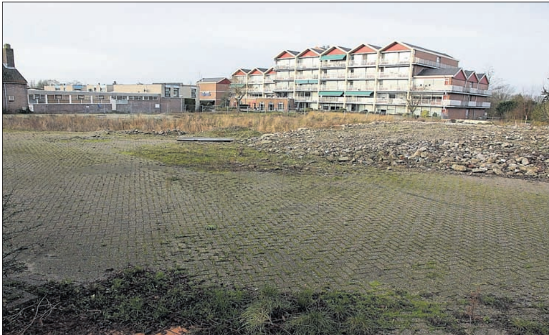
Nu nog braakliggend, maar straks verrijst hier het nieuwe zorgcentrum Zonnehof Mijdrecht.
