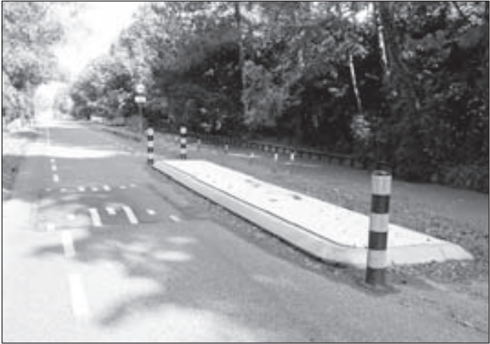
Recent aangelegde en gevaarlijk gebleken chicanes worden verwijderd
