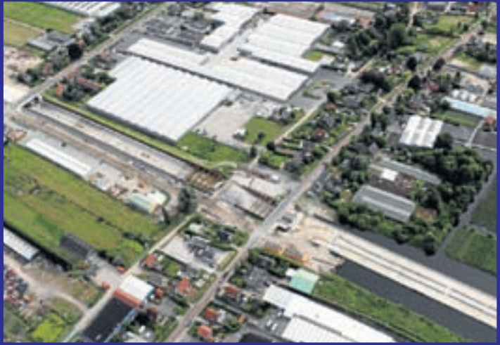
De Waterwolf tunnel in de N201 met het midden de Oosteinderweg en de Hoge dijk. Rechts beneden het gesloten tunneldeel, links het open gedeelte. Geheel links de Aalsmeerderweg (Bron: Projectbureau N201+)
