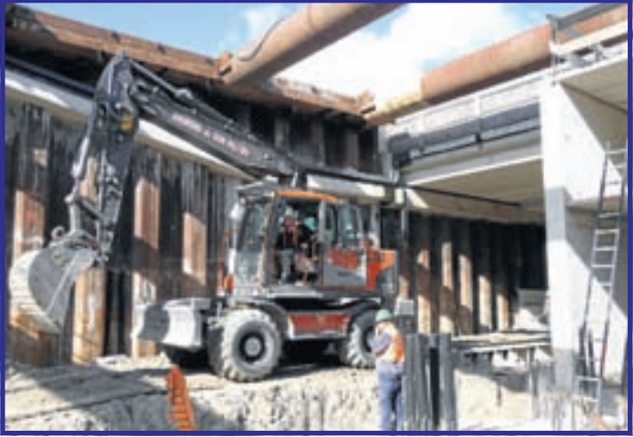
Tunnelbuis ingang Aalsmeerszijde. Het middentunnelkanaal moet nog worden verlengd. Boven de graafmachine kruist de Oosteinderweg
