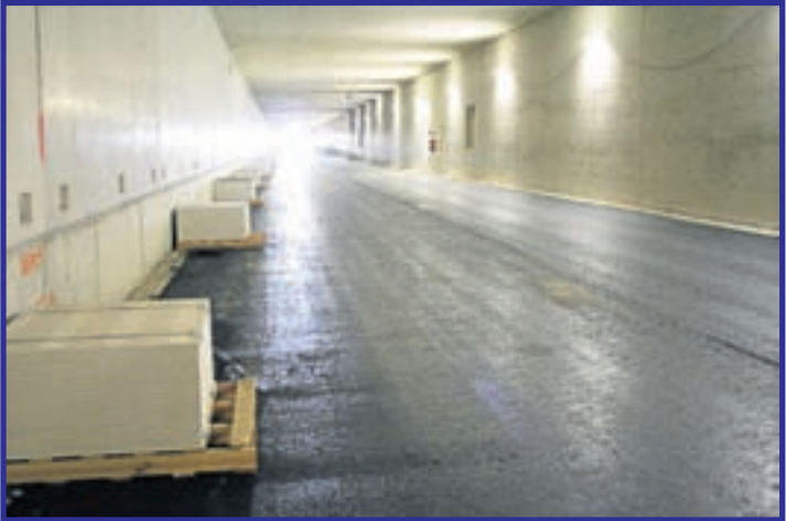
In één van de tunnelbuizen is de onderlaag voor de rijweg al aangebracht. Links pallets met brandwerende tegels
