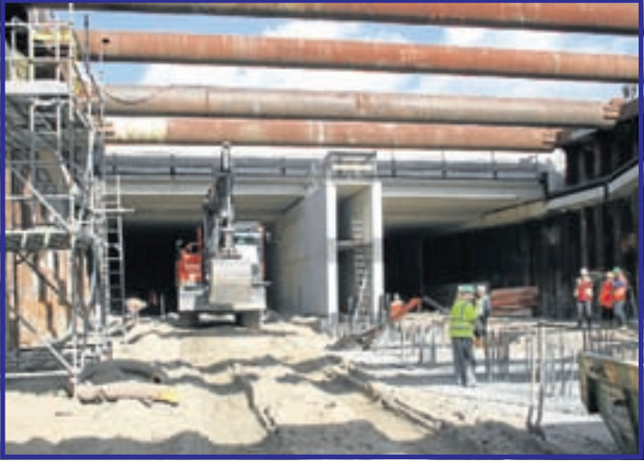
Tunnelbuis ingang Aalsmeerszijde. Het middentunnelkanaal moet nog worden verlengd. Boven de graafmachine kruist de Oosteinderweg
