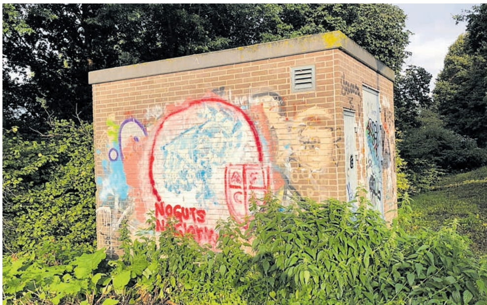
Het trafohuisje bij de Driehuisschool
