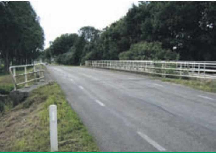
ONDERHOUDSWERKZAAMHEDEN BRUIJNEBRUG IN WILNIS
