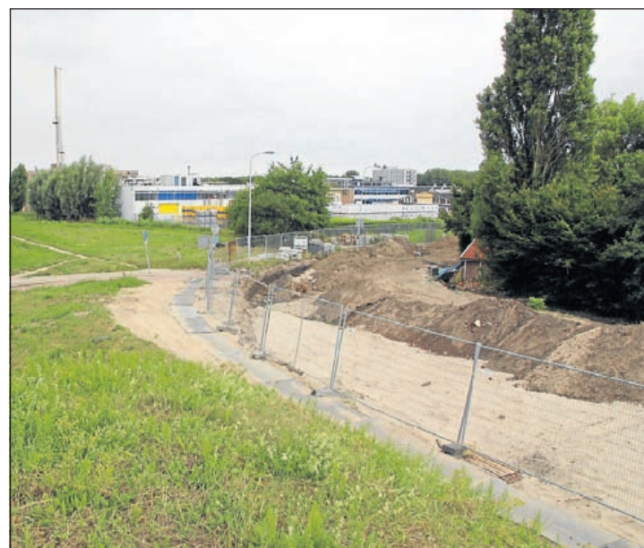
Volgens de gemeente wordt 1 september begonnen met de werkzaamheden aan de onderdoorgang van de busbaan
