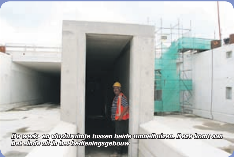
Bouw van de tunnel in het Bovenland
