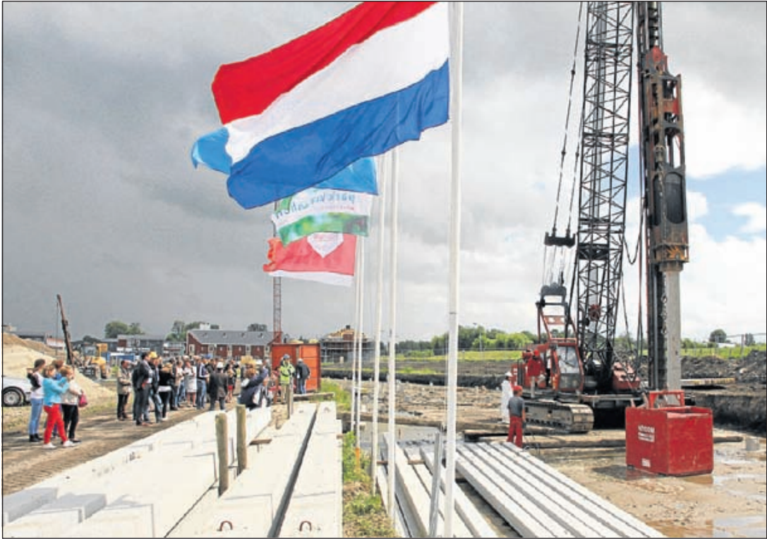
Mijdrechtenaar Martin Troost slaat in Park Krayenhoff een heipaal in de grond voor de nieuwbouw van zeven Liniewoningen
