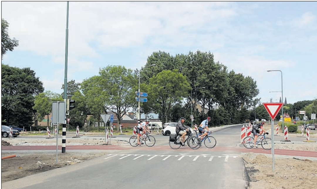
Op de kruising bij de Piet Heinlaan in Amstelhoek hebben fietsers voorrang. Op de nieuw aangelegde rotonde achter het benzinestation niet!
