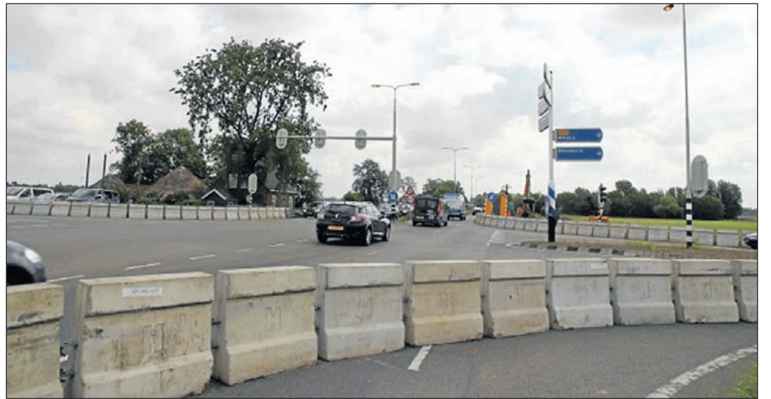
De voorbereidende werkzaamheden voor aanpassing van het kruispunt N201/N212 zijn in volle gang
