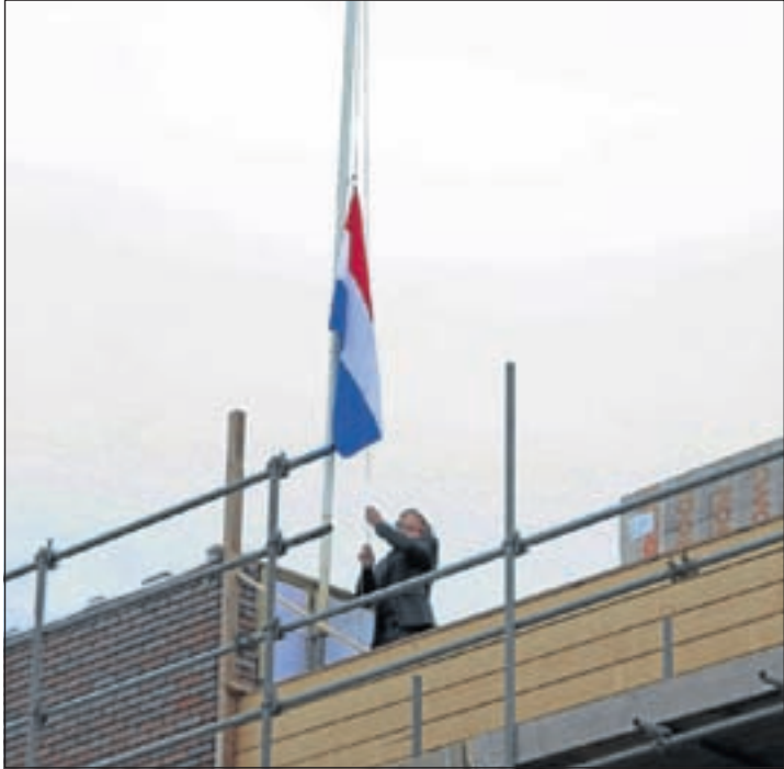
Het hoogste punt van de bouw is bereikt; toekomstig bewoner Michael Mica hijst de vlag in top
