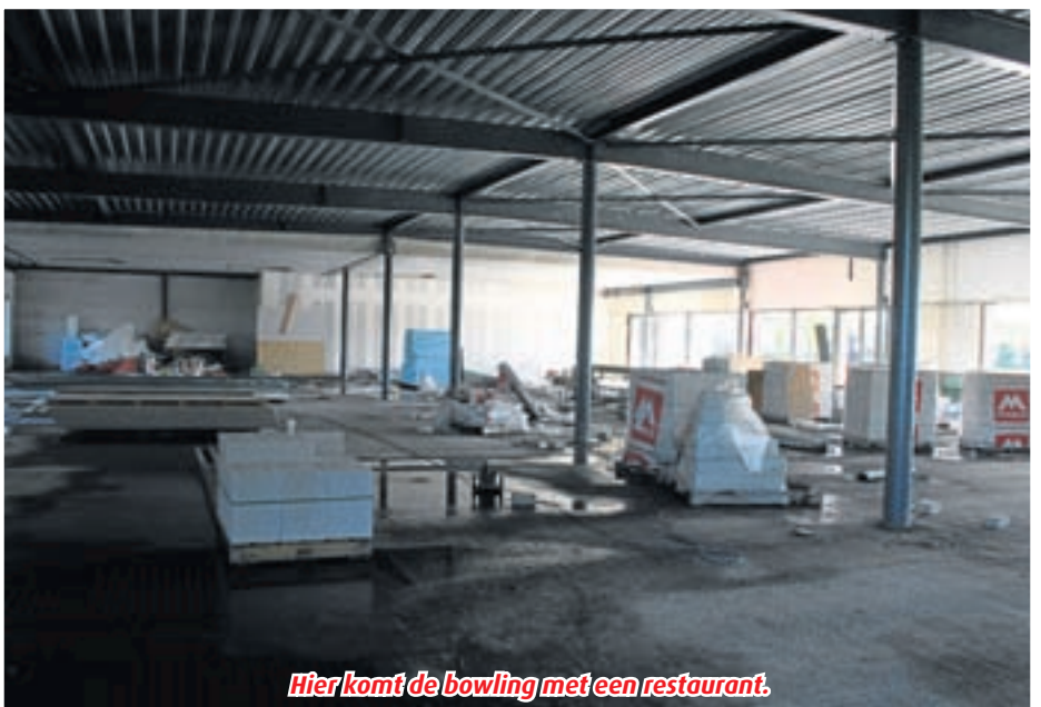
Nu nog een ‘bouwplaats’, maar in september moet het gereed zijn.
