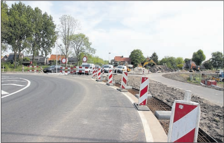
Aansluiting met Mijdrechtse Zuwe richting N201/Tienboerenweg nog in aanleg
