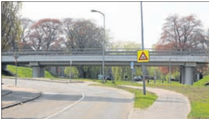
Het reeds lang geleden gebouwde viaduct onder de busbaan verbindt straks de Amsterdamse weg met het centrum van Uithoorn
