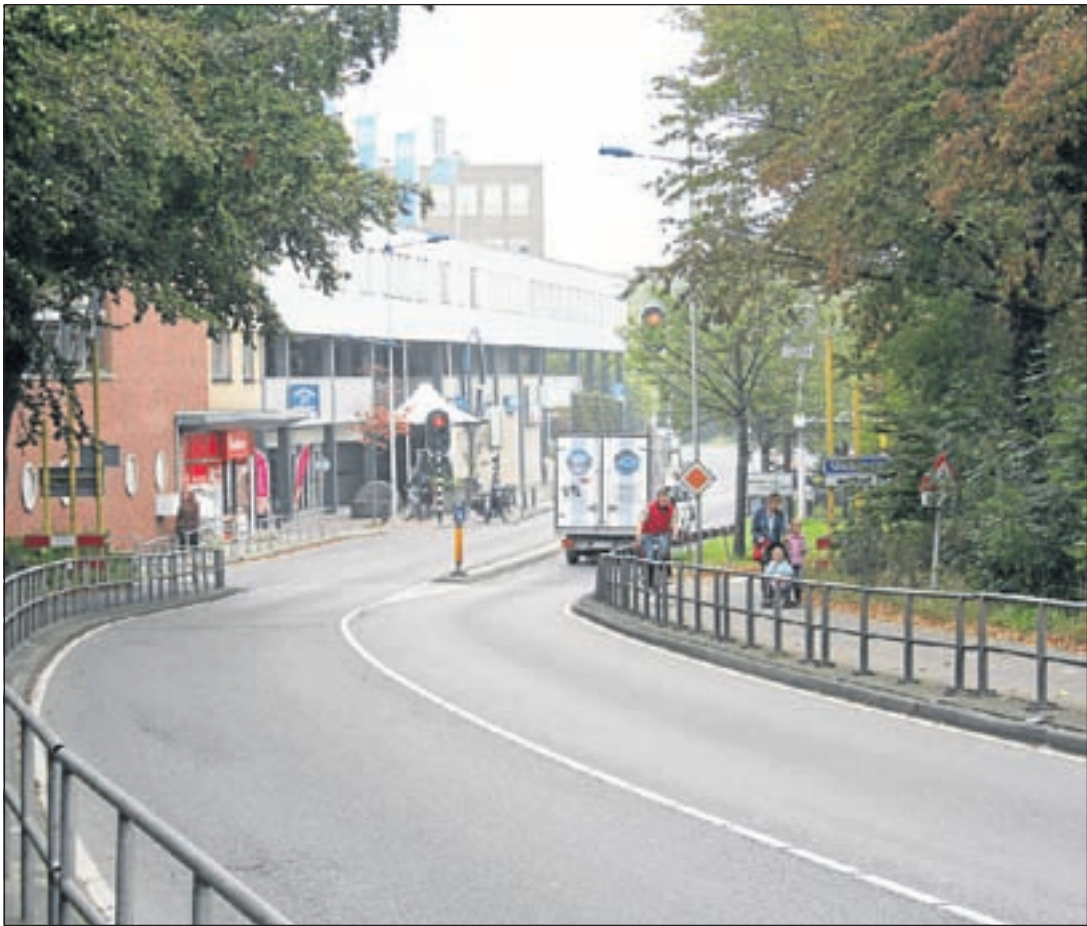
Als de ondergrondse parkeergarage onder het Amstelplein er komt wordt dit de toerit
