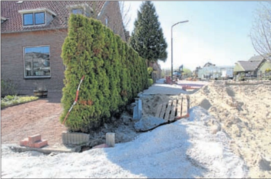
Het verschil in hoogte tussen gerenoveerde straat en de tuinen is hier goed te zien
