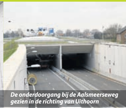
Toegang tot de tunnel met daglichtdempende constructie
