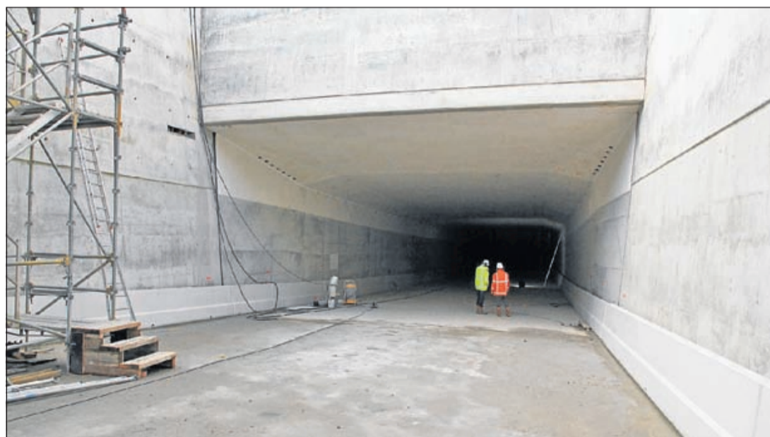
Het werkelijke tunneldeel voorbij de noodkering, is in ruwbouw klaar. Je kunt tot aan de waterkering in het midden van de Amstel, waar het Uithoornse deel aansluit, 70 meter de tunnel in lopen
