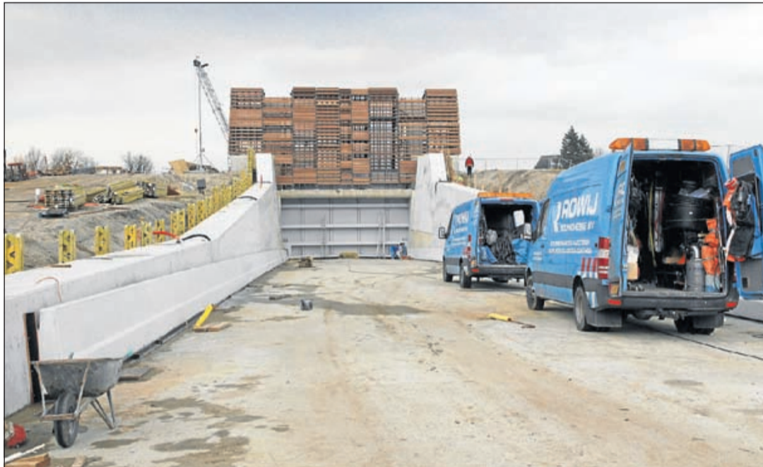
De toegang naar het aquaduct gezien vanaf de Rondeveense kant met de neergelaten noodsluif en de sierconstructie er bovenop
