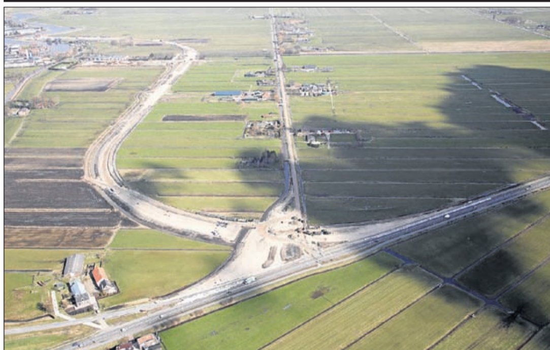
Het tracé van de N201 naar het aquaduct (uiterst links boven) is al helemaal zichtbaar. Ook het kruispunt bij de Tienboerenweg (midden) krijgt al vorm. Recht naar boven is de Tienboerenweg, links onder de huidige N201 naar Amstelhoek/Uithoorn, rechts naar Mijdrecht (Foto: Projectbureau N201+).
