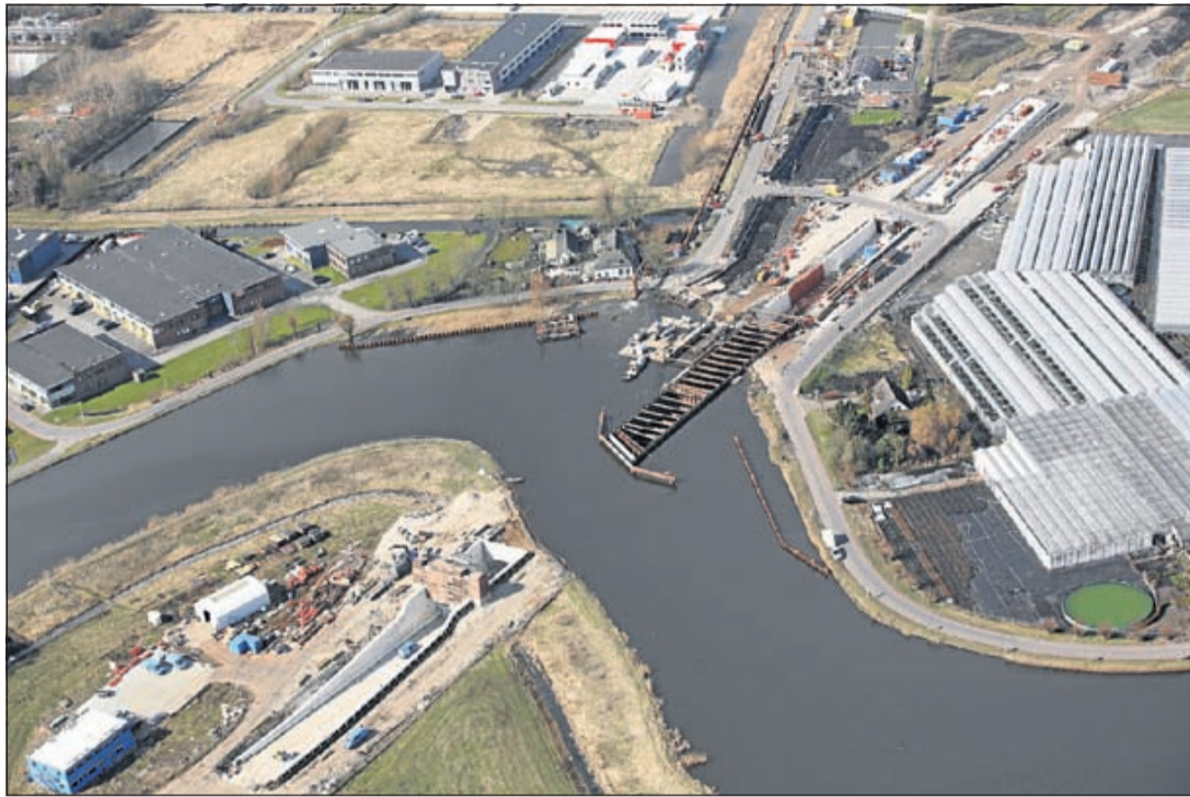
Luchtfoto van het in aanbouw zijnde aquaduct bij Amstelhoek/Uithoorn. Links het deel aan de Rondeveense kant dat in het afbouwstadium verkeert, rechts de bouw naast de Hollandse Dijk in Uithoorn (Foto: Projectbureau N201+).
