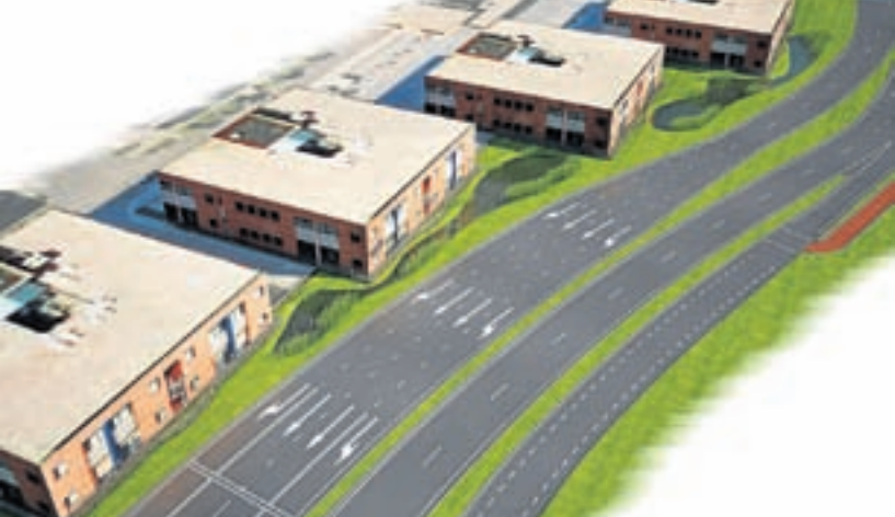
De Fokkerweg krijgt 2 x 2 rijstroken. Rechts daarvan op de foto is de parallelweg te zien voor ontsluiting van de bedrijven aan de oostkant van de Fokkerweg
