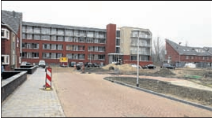
De bestrating vordert gestaag op de Geometrielaan. Op de achtergrond het appartementencomplex Stellinghof en rechts de hofwoningen
