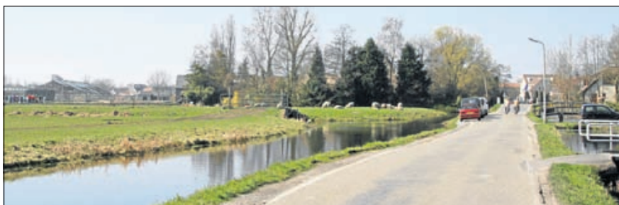
Metertijd wordt de Boterdijk na een groot onderhoud het domein voor de fietsers in de vorm van een 'fietsstraat'
