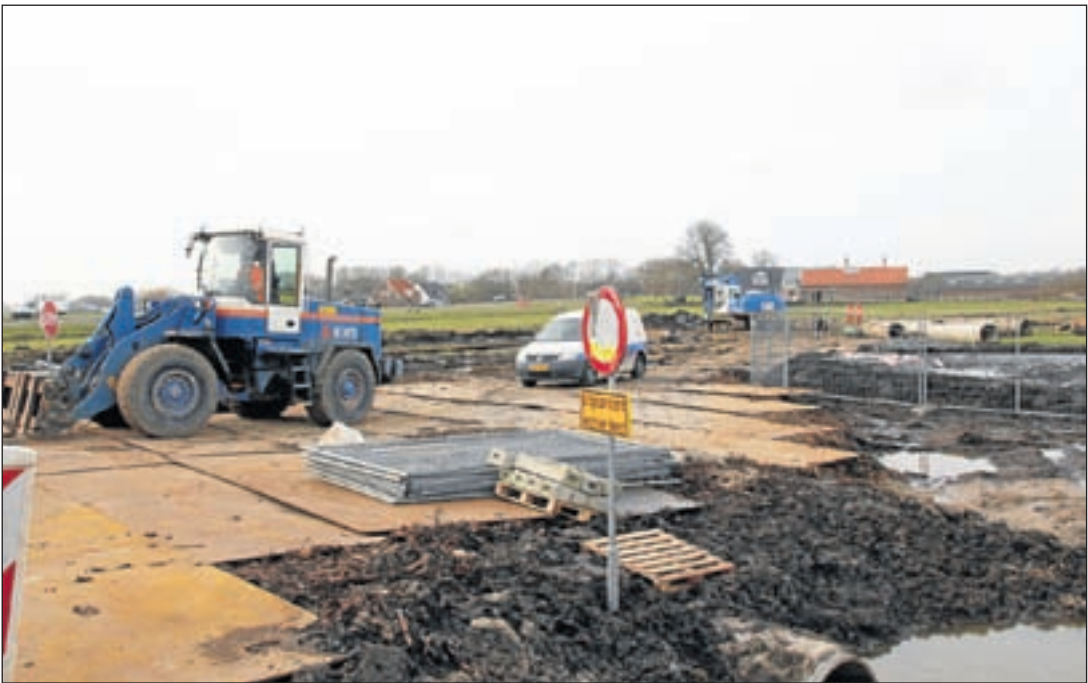
Start van de omlegging van de N201 bij de Tienboerenweg. Op de achtergrond de huidige provinciale weg
