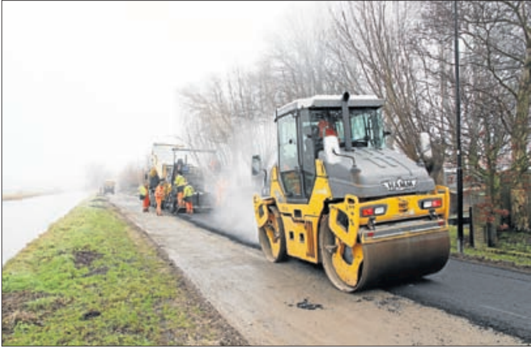
De wegenbouwers aan het werk om een tijdelijke noodweg aan te leggen
