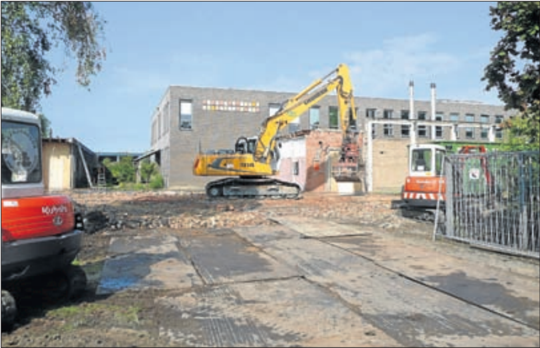
In juli, tijdens de zomervakantie, is gestart met het slopen van een deel van de gebouwen van het Wellant College in de Jac. P. Thijsseaan. Inmiddels is aangevangen met de nieuwbouw. Een school van iets meer dan 1.400 vierkante meter gaat gebouwd worden. Ook krijgt het Wellant College een nieuwe sportzaal van ongeveer 1.000 vierkante
