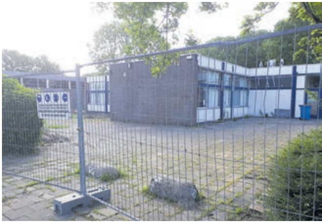
Van in gebruik als buurthuis, tot klaar voor de sloop en bouwrijp gemaakt terrein. Dit laat overigens nog wel enige tijd op zich wachten. Voor woningbouw hier zijn plannen, maar dit zit nog in de ontwikkelingsfase.
