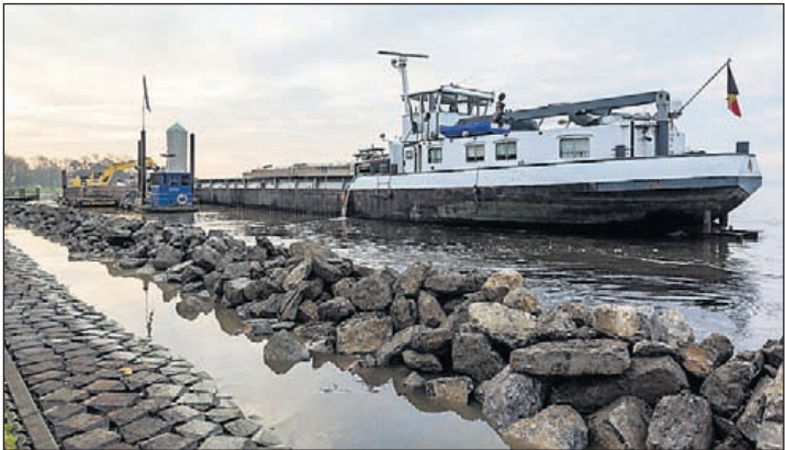
"Het Hoogheemraadschap van Rijnland is begonnen met het versterken van de Westeinderdijk aan de Stommeerweg, zodat Aalsmeeders ook in de toekomst droge voeten houden. Maar onze 'wandelpark' wordt er niet mooier op en de Poel wordt niet toegankelijk", aldus een reactie van Wim Rietveld, tevens maker van deze mooie foto.
