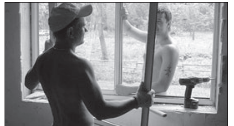
Onlangs zijn nieuwe ramen geplaatst in het gebouw.
