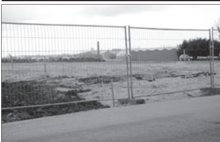
De bouwweg, genomen vanaf de Hornweg. Al helemaal klaar!
